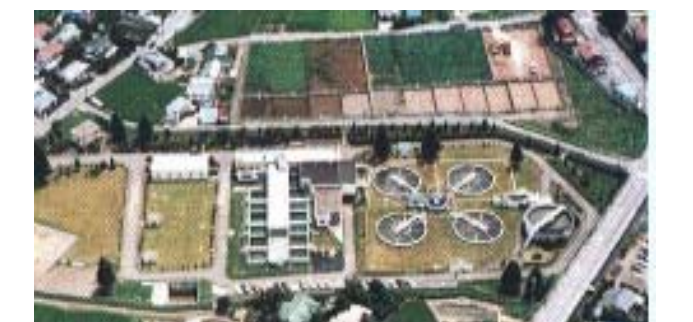
図 4：長野県企業局は上田市に県営上田水道管理所を昭和 39(1964)年に完成させた。産業廃棄物が毎日大量にでる。畑みたいな場所は天日乾燥床。1日に 48,000 トン、給水人口は 61,700 人である。水道料金も高く、水質も良くない。臭い水事故が多々ある。後追いで、次から次への付帯施設を建設している。未完成の欠陥処理である施設は、高度な技術が必要で業者頼みの施設である。
