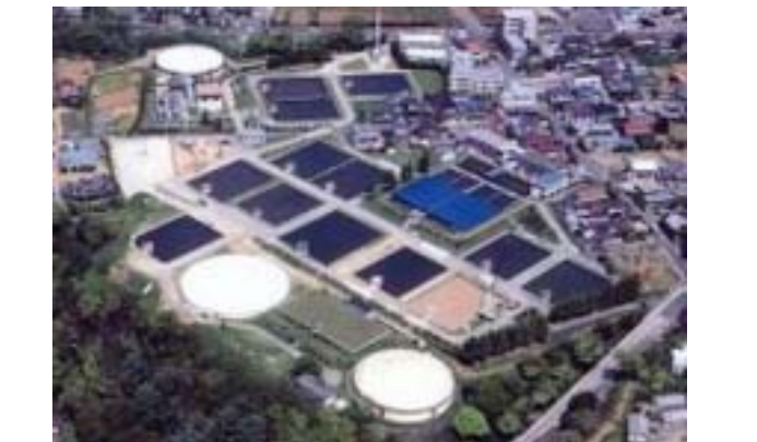
図 5：上田市染屋浄水場。780m2 のろ過池が 13 池ある。標準
