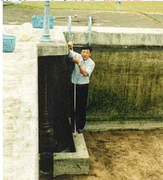
図 18：ろ過池で藻類を繁殖させないようにと水深が深かった。底まで光りが届かないように、水压を高くした藻類被膜を浮
