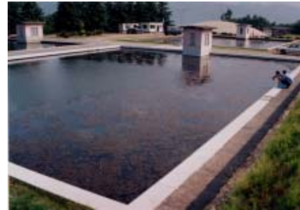
図11：1924(大正13)年に完成し、現在も稼働している東京都水道局の境浄水場。長さ86.7m、幅54.2m(面積4630m 2 )のろ過池が20池。標準ろ過速度の1日に4.8mでろ過すると、1池で2万2224トンの飲み水ができる。最大給水量を1人1日の300リットルとすると1池で7万4000人分の量。この浄水場だけで150万人近くの水道需要をまかなえる。
