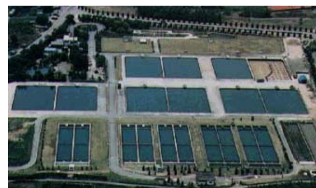
図 2：1964（昭和 39）年に完成した若田浄水場。この浄水場は、一般市民に一年中 365 日、開放している。
