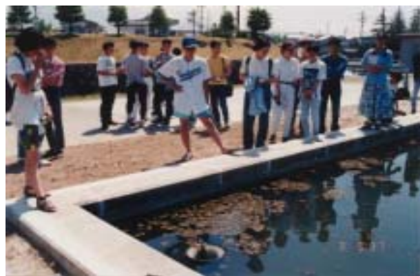
図 14：浮いてくる藻を自動排出させる越流管がある。この藻は捕集すれば、肥料や飼料にもなる。
