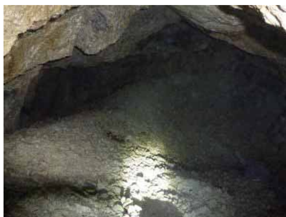
試験湛水後の CR-1 の洞窟内の状況
