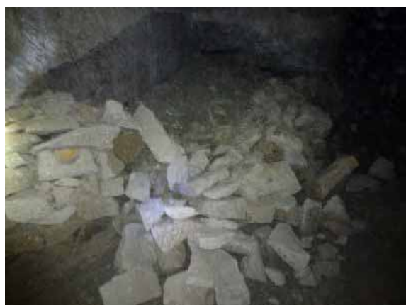
試験湛水後の CR-1 の洞窟内の状況
