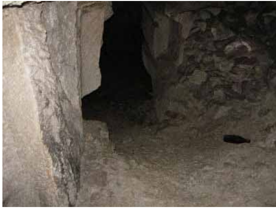
試験湛水後の CL-1 の洞窟内の状況 (6月11日撮影、ほぼ水がひいている)
