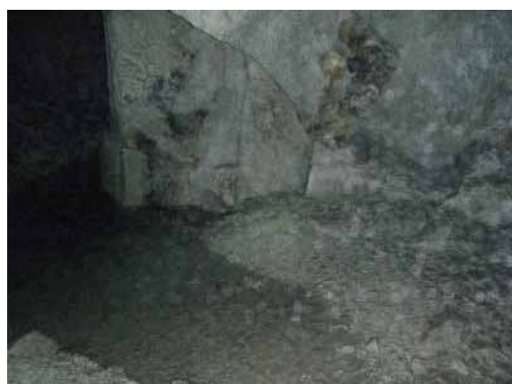
試験湛水後の CL-1 の洞窟内の状況 (6月5日撮影、まだ水が残っている)
